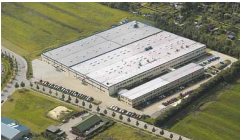
La sede social en Cuxhaven en el Mar del Norte, vista aérea.
